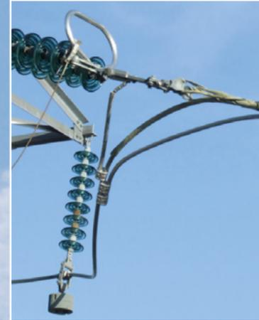
◀ spezielle OPPC Doppelspiralabspannung mit Isolator, Tragklemme und Zusatzgewichten.
