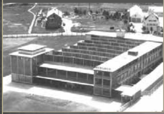
1955 Neubau der Elektroarmaturenfertigung Werk II.
